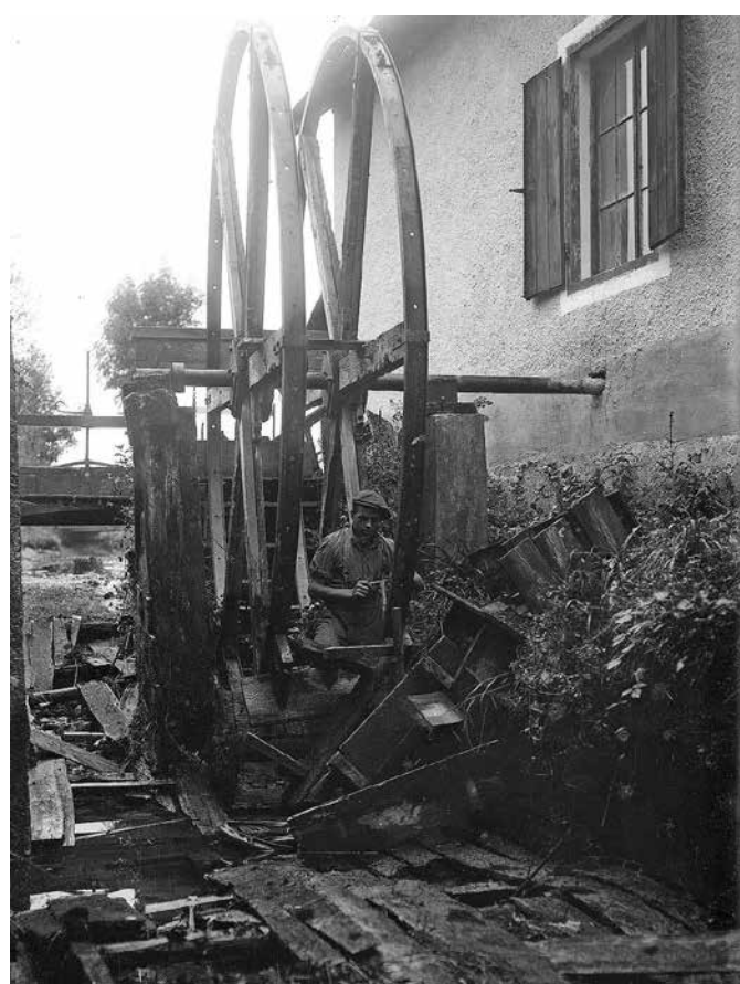
■ Vodno kolo (zgoraj), ki ga je gnal potok Mlinščica, je bilo že od konca 19. stoletja vir pogonske moči v delavnici Nagličevih. Leta 1927 so ga nadomestili s francisovo turbino (spodaj).
