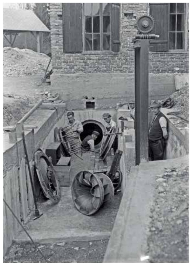
■ Vodno kolo (zgoraj), ki ga je gnal potok Mlinščica, je bilo že od konca 19. stoletja vir pogonske moči v delavnici Nagličevih. Leta 1927 so ga nadomestili s francisovo turbino (spodaj).
