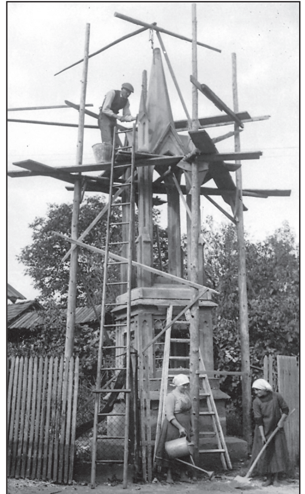
Gradnja Končkove kapelice leta 1919
