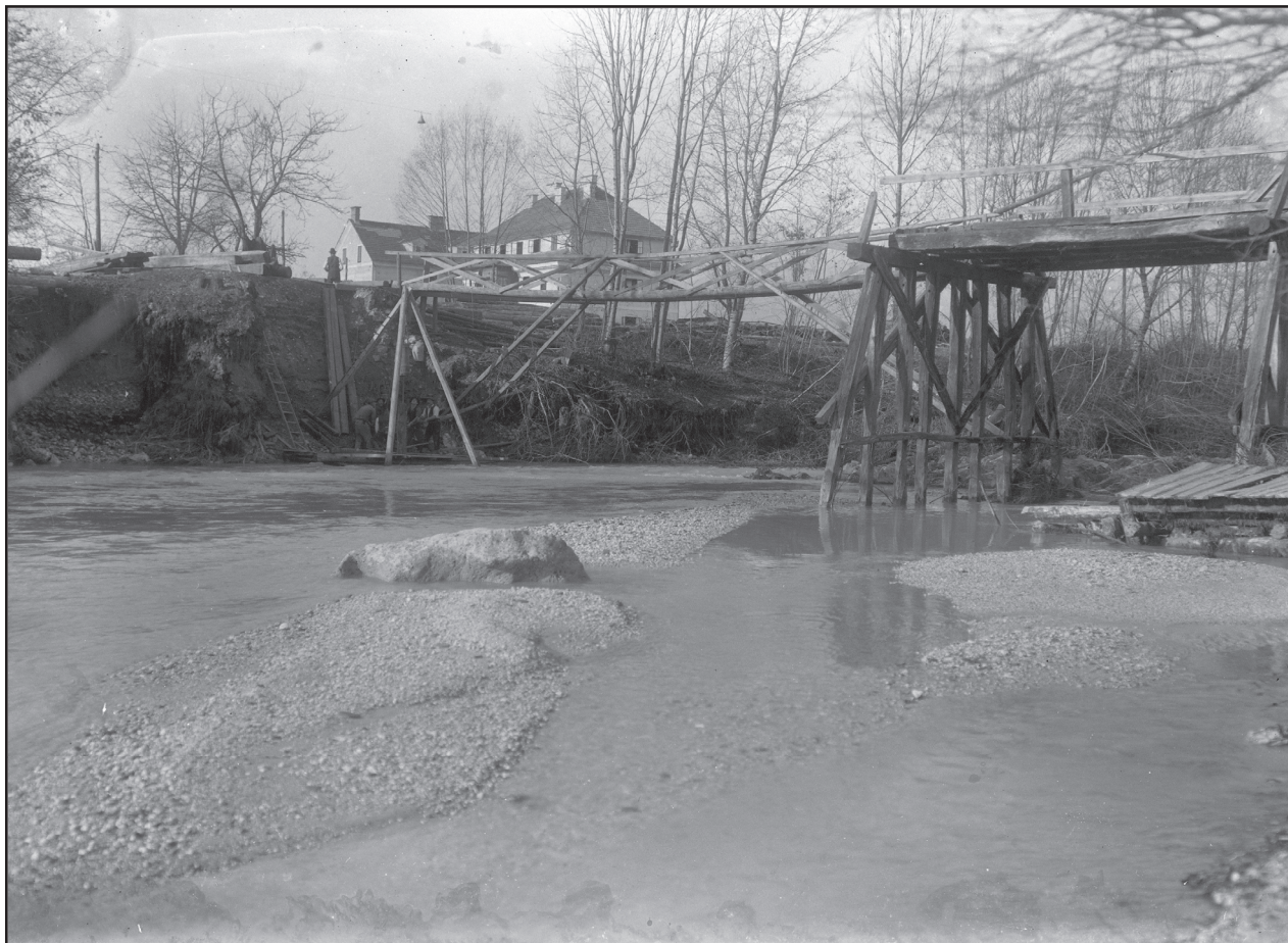
Poplave na Duplici – zasilna brv ob podrtem mostu okoli leta 1924
