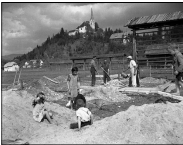
Otroci med igro na gradbišču homškega gasilskega doma, 1933
